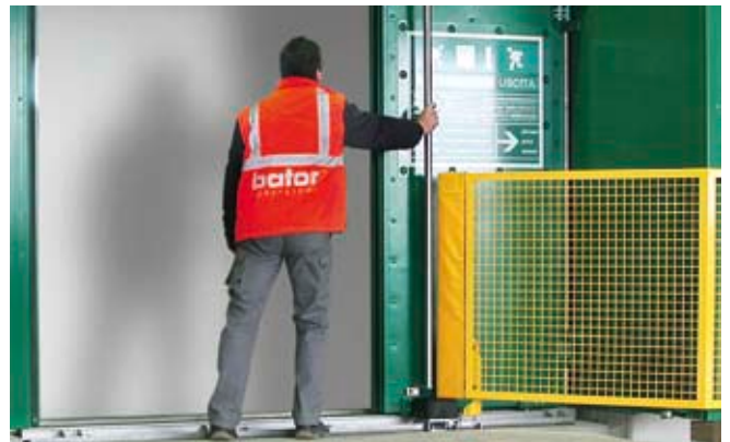
Fertig gestellte Querschlagstüre im geöffneten Zustand. Collano Klebstoffe sind eine wichtige Komponente bei den Sicherheitstüren im dereinst mit 57 km längsten Hochgeschwindigkeits-Bahntunnel der Welt.
