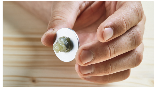
Avant tout contact avec la colle, enduire les assemblages vissables avec l'agent de séparation Collano HP 2000.
